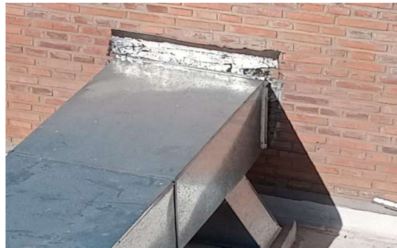
Colocar babetas de amure en conductos existentes
